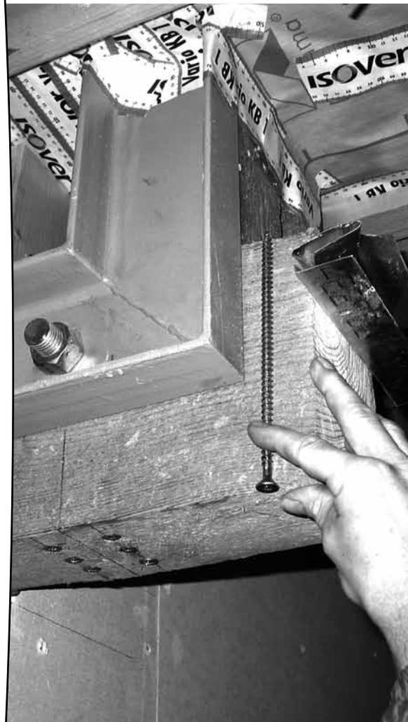
Nachträgliche Querzugverstärkung mittels SPAX 8,0 x 200 mit Vollgewinde
